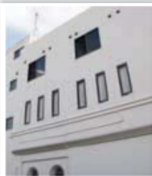
白を基調とした外壁
