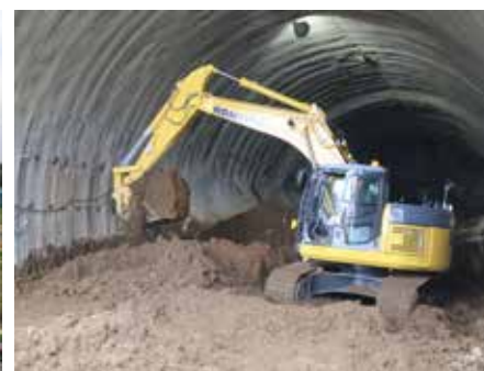
高取山トンネル
